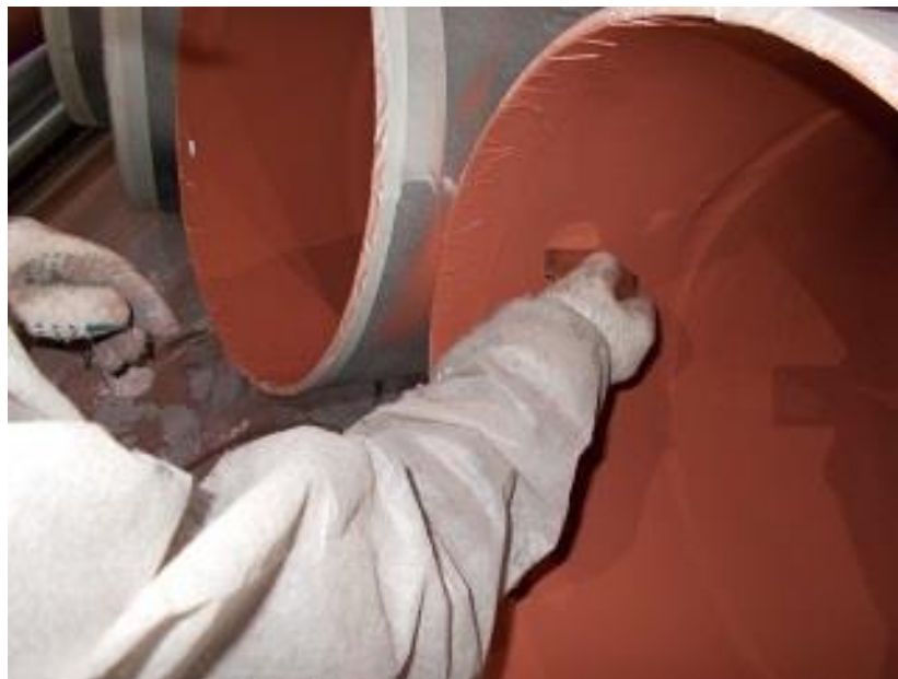
Фото 01. Контроль толщины мокрого слоя
